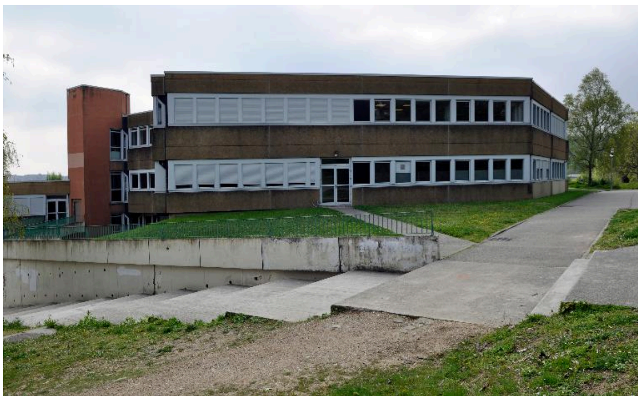
Bâtiment A, élévation nord-ouest
