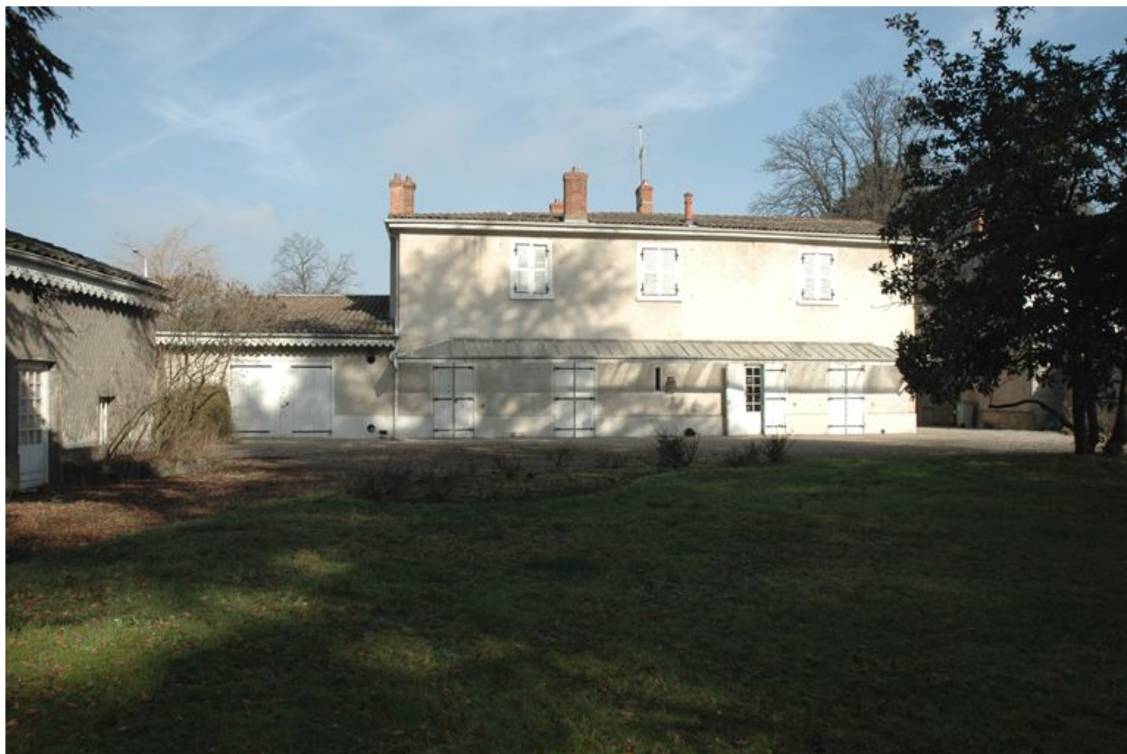
Vue de l'élévation antérieure, côté jardin
