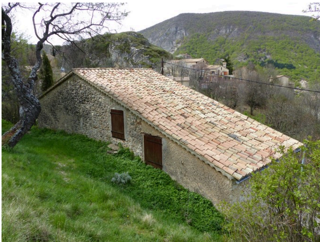
Vue d'ensemble prise du nord-ouest.
