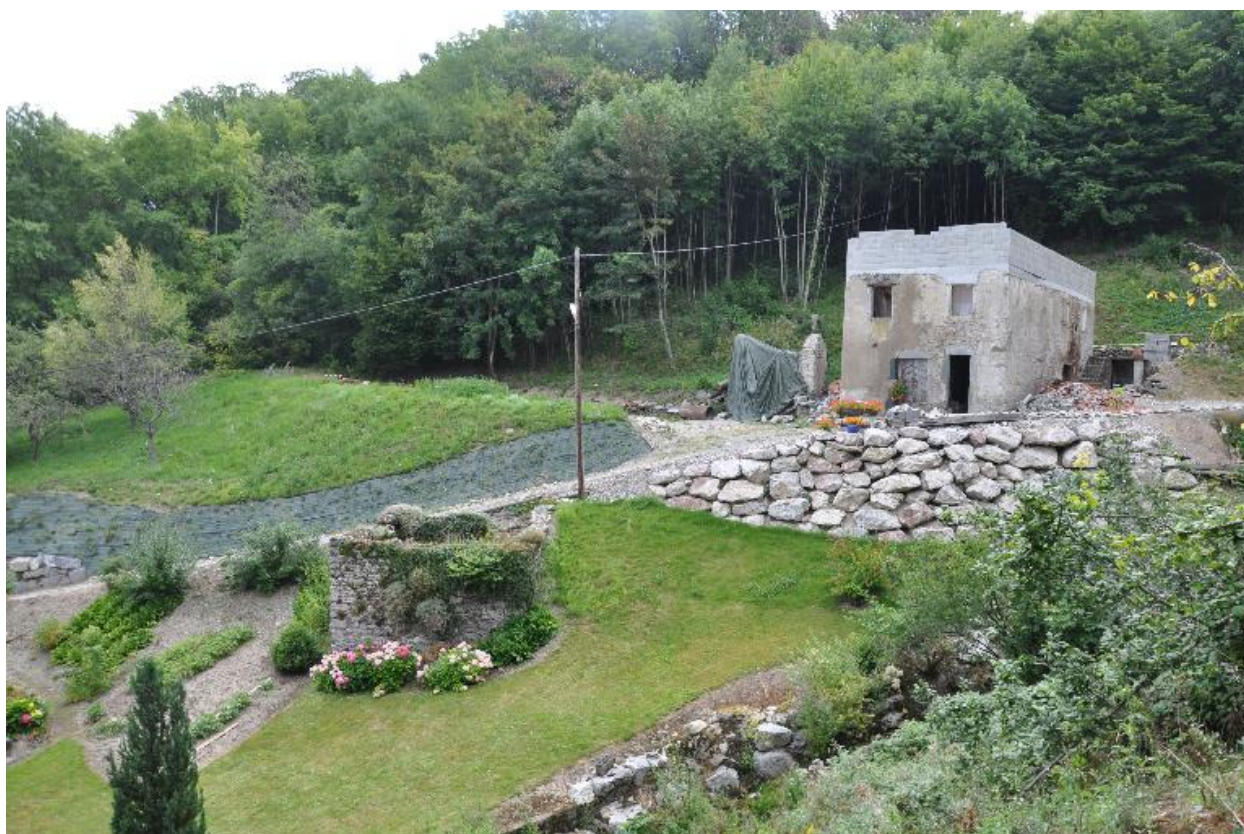
Vue générale du bâtiment du moulin situé en amont
