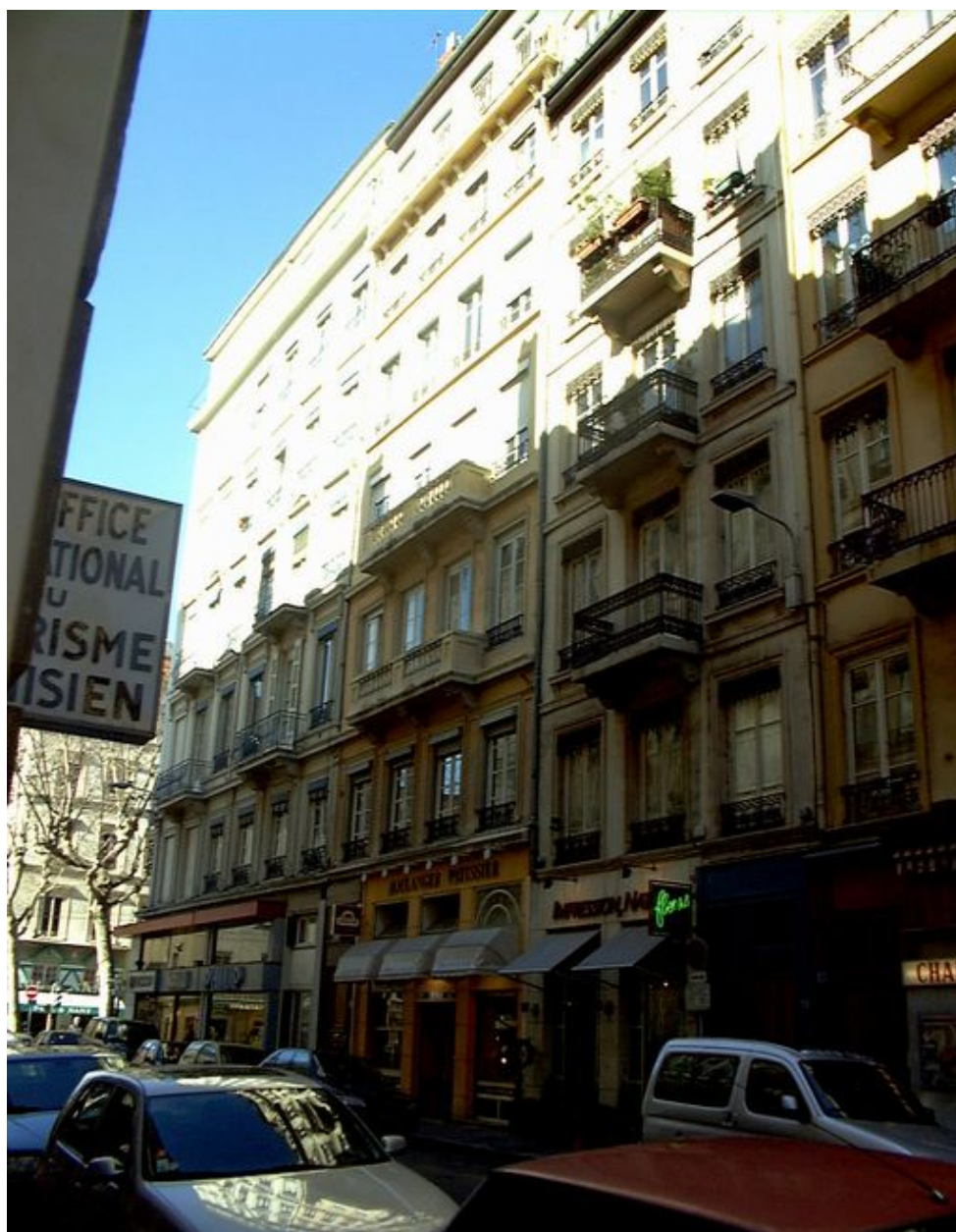
Façade sur rue, vue générale
