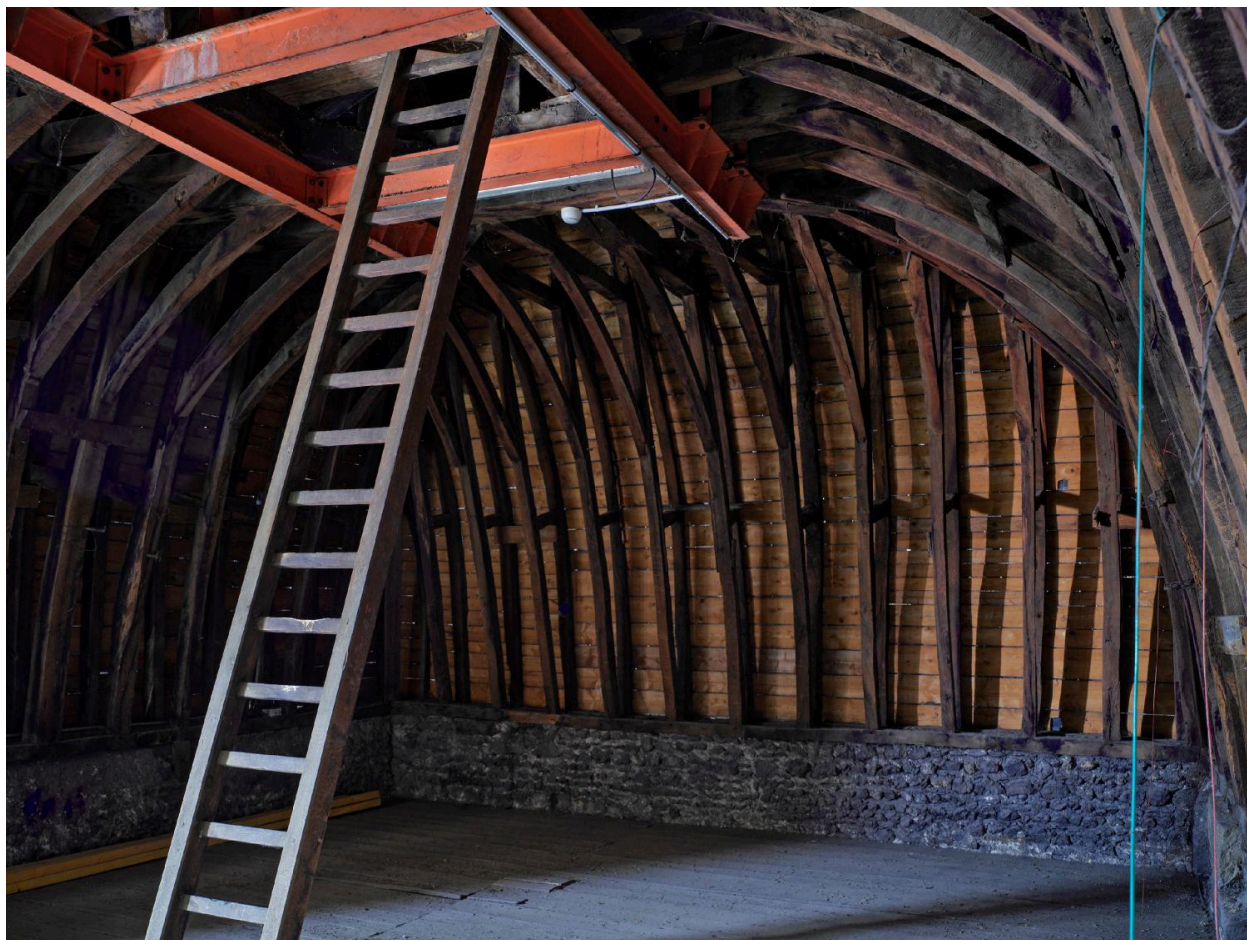
Pavillon est : charpente du comble
