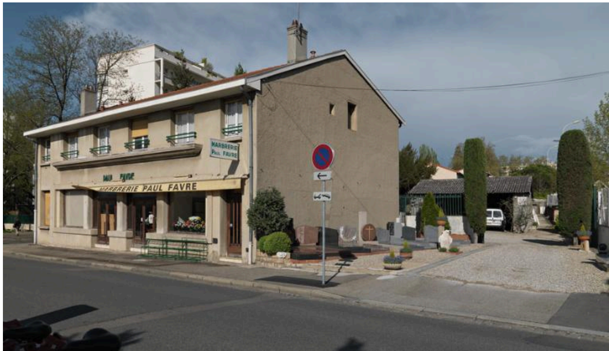
Vue d'ensemble depuis la rue Philippe-de-Lassalle
