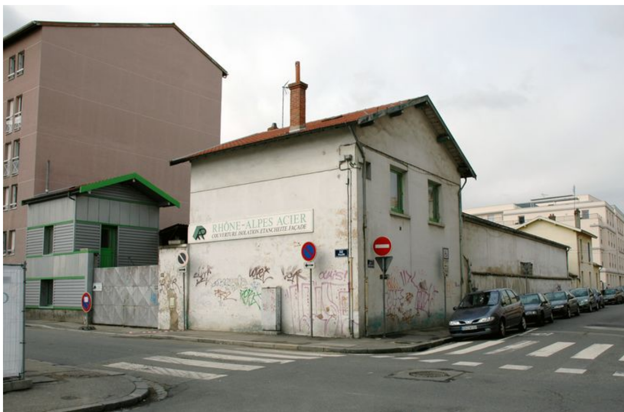
Vue de la façade antérieure depuis l'est
