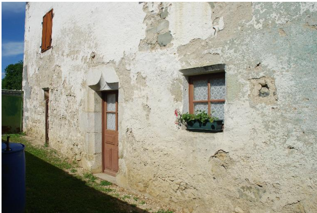
Vue partielle de la façade principale, orientée à l'ouest.
