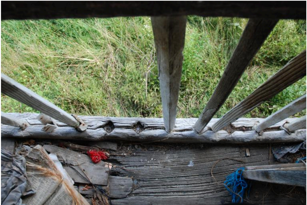
Détail du garde-corps du balcon.
