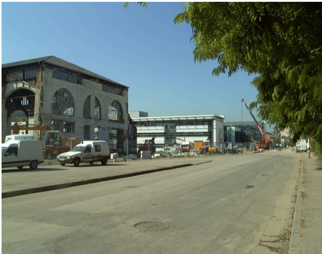
Vue nord-ouest de l'entrée de la halle de la navigation (rue des Docks)
