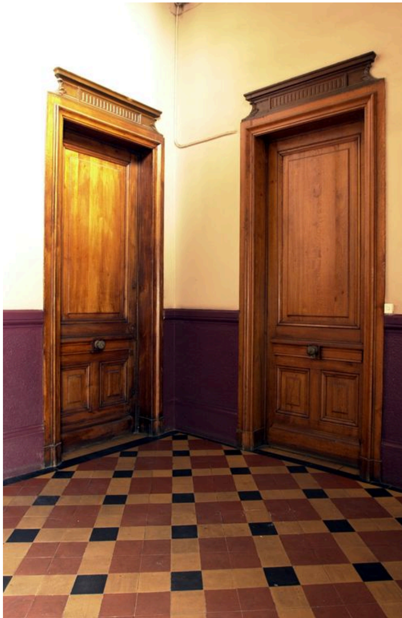
Porte palière du rez-de-chaussée
