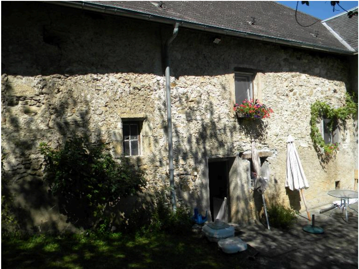
Vue de la façade arrière.
