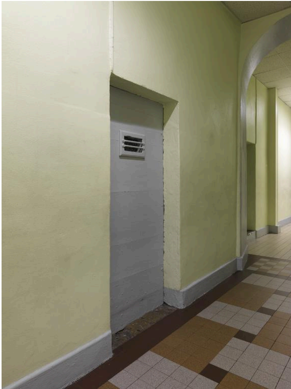
Corps de bâtiment sud, 1er étage, couloir longeant le chevet de la chapelle de la Trinité : porte d'un ancien débarras
