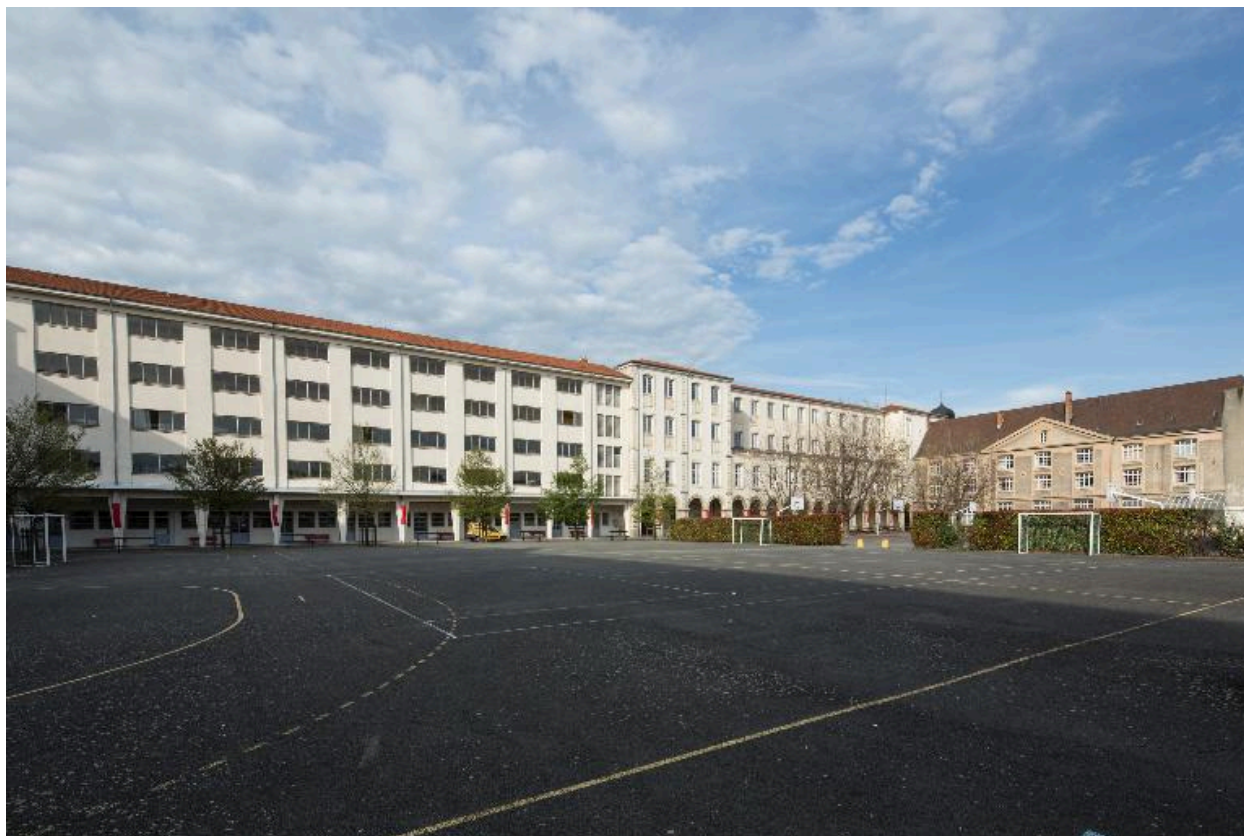
Bâtiments B et H. Façades sur cour
