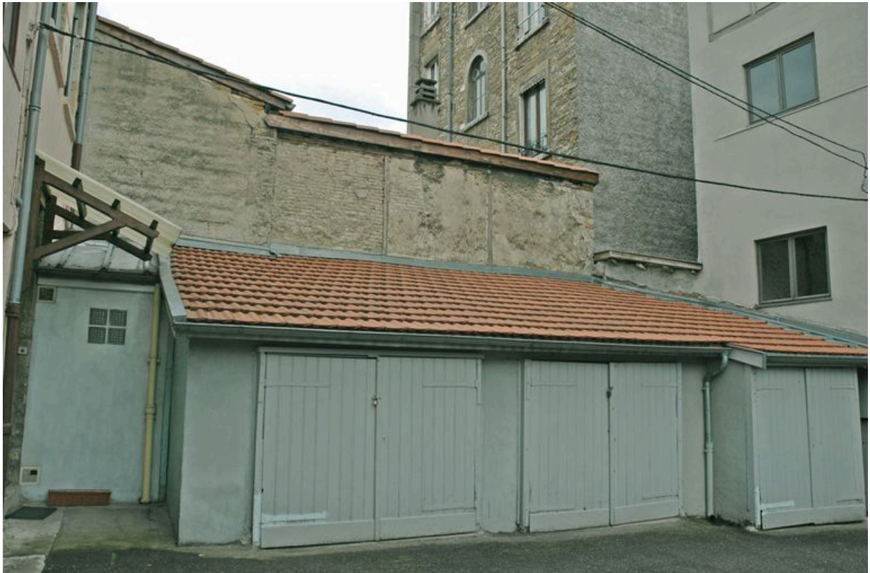
Garages situés le long du côté sud de la cour, vue depuis l'angle nord-est
