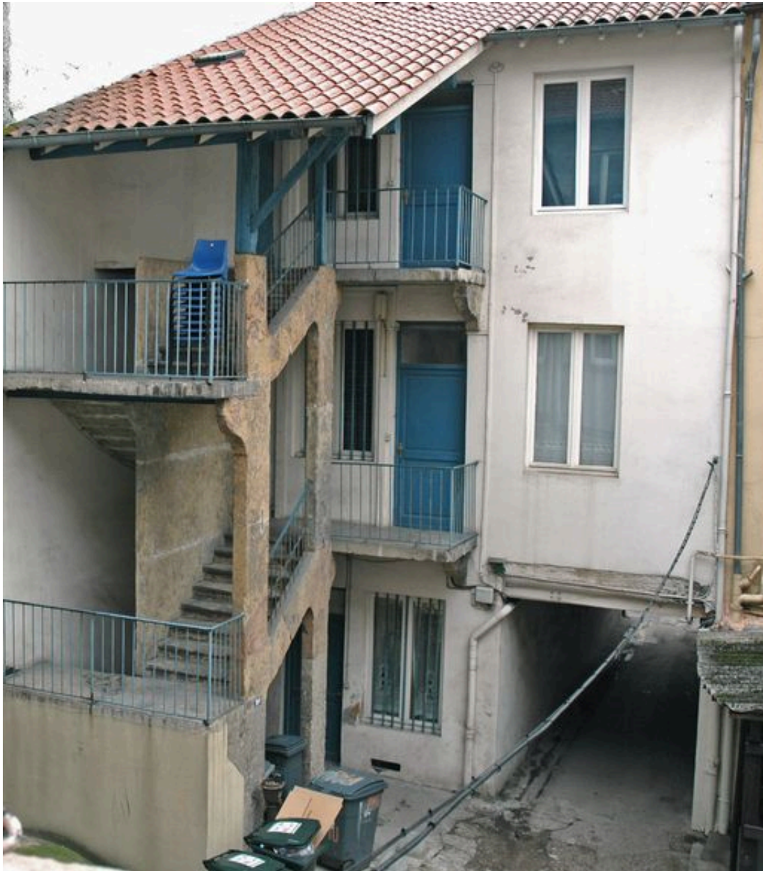
Vue de la façade est sur cour vue depuis la cage d'escalier de l'immeuble en fond de cour
