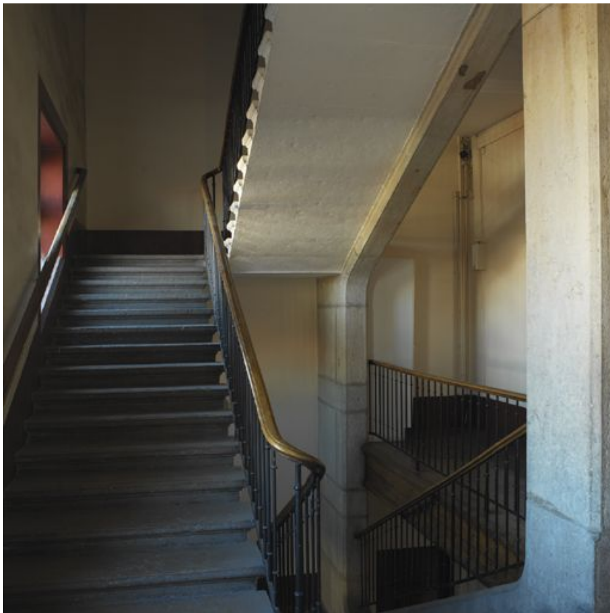
Vue de l'escalier du corps de bâtiment sud
