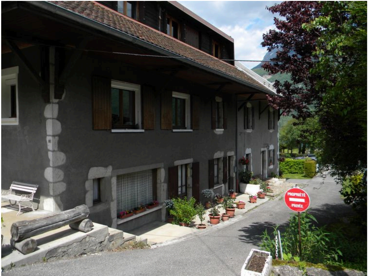
Vue de la façade sud.
