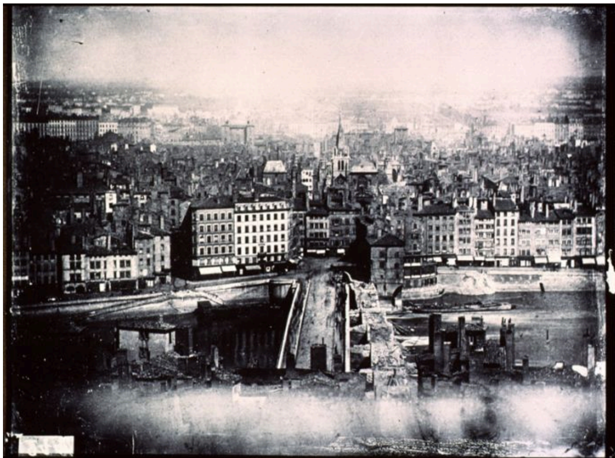
Démolition du pont de Pierre, pont de Nemours terminé, fotogr., ca 1846
