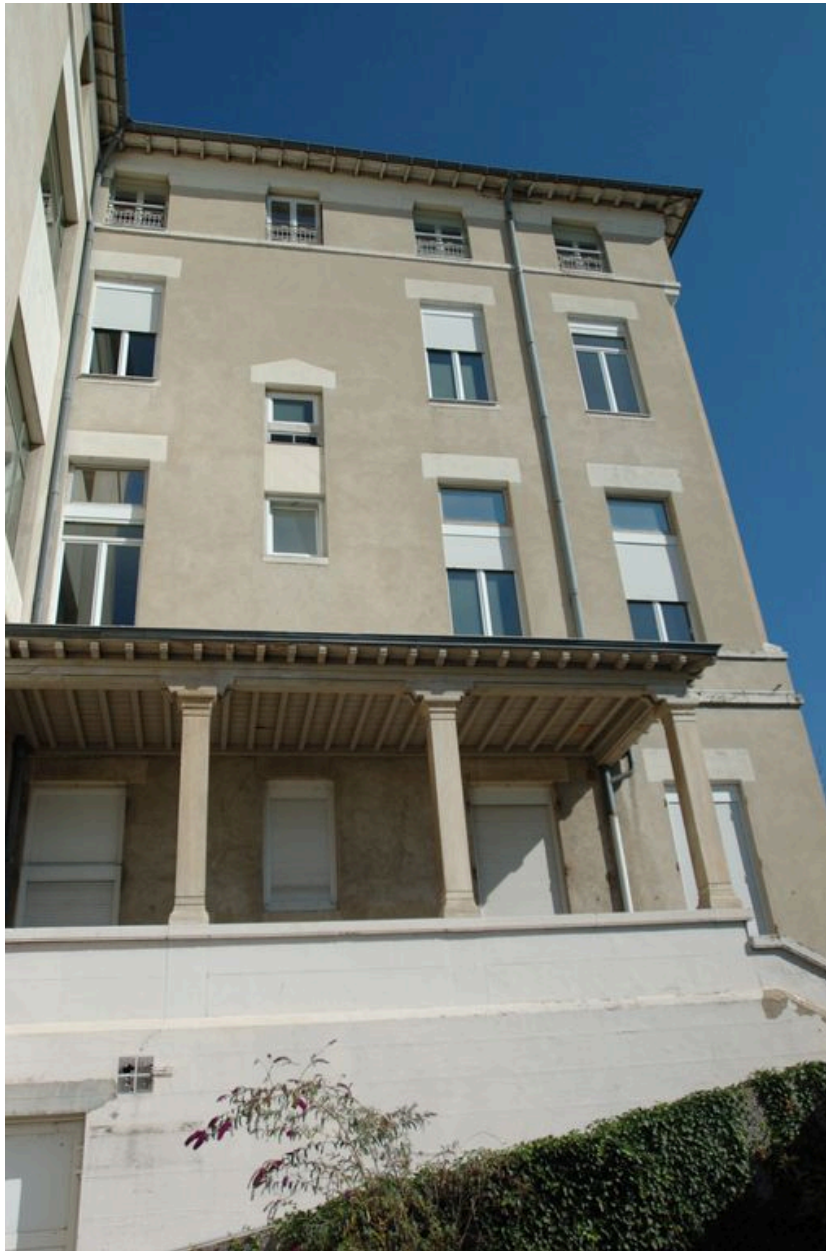
Vue de l'ancien bâtiment des malades (élévation sud), en octobre 2011.
