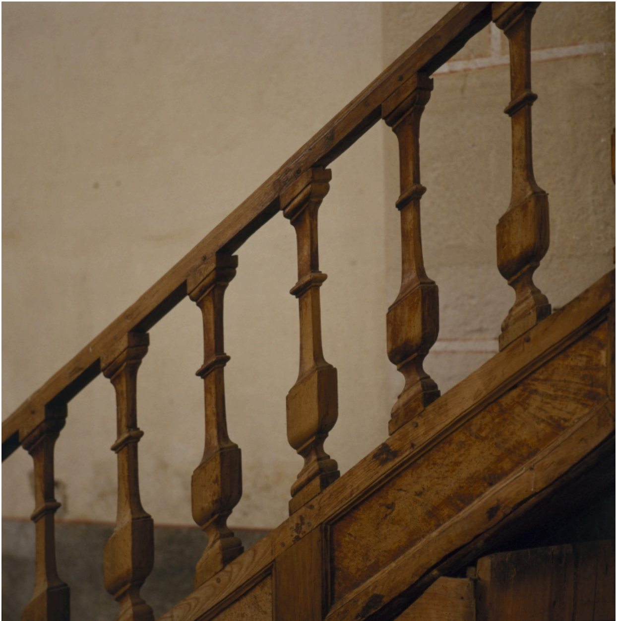
Détail de la rampe.
