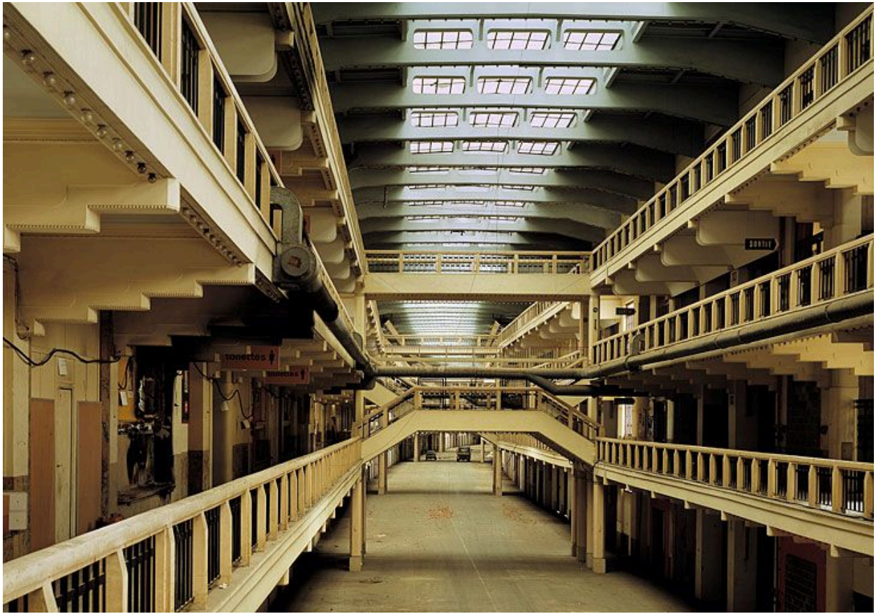
Vue générale de l'intérieur : passerelles et galeries
