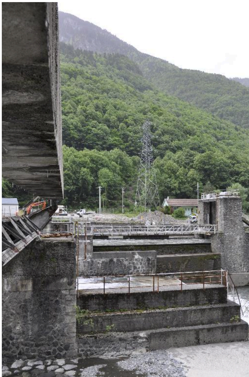
Vue des installations du barrage de Pierre-Ebaysse
