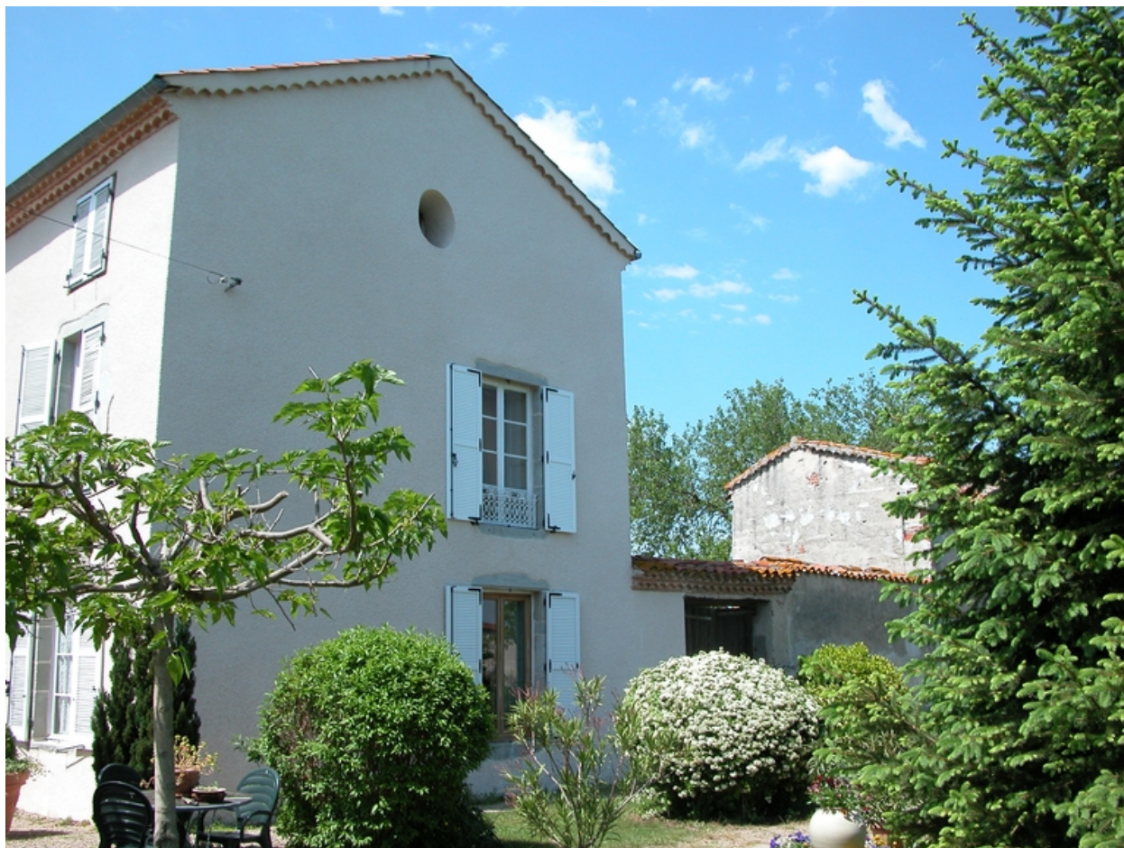
Vue du pignon est de la maison de maître, et du clos du pigeonnier (portail).
