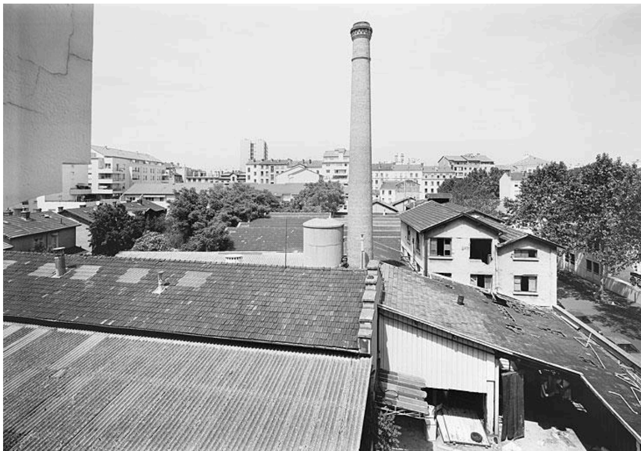
Vue d'ensemble de l'usine et de sa cheminée
