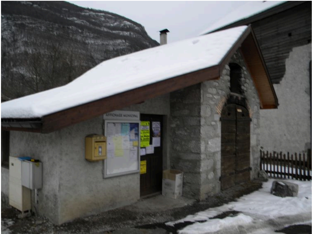
Vue générale de l'ancien hangar aux pompes et du pèse-lait depuis la rue.
