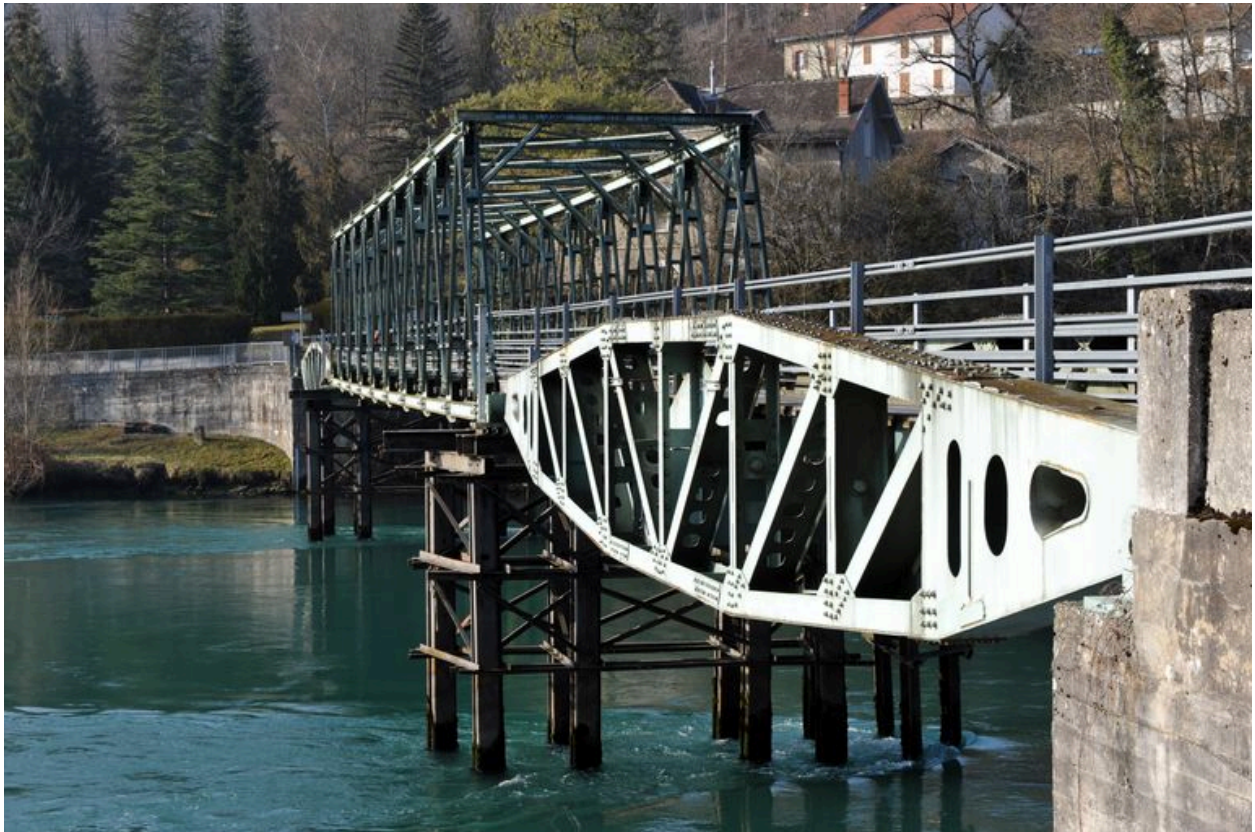
Vue générale, de côté, face aval (depuis la rive gauche)
