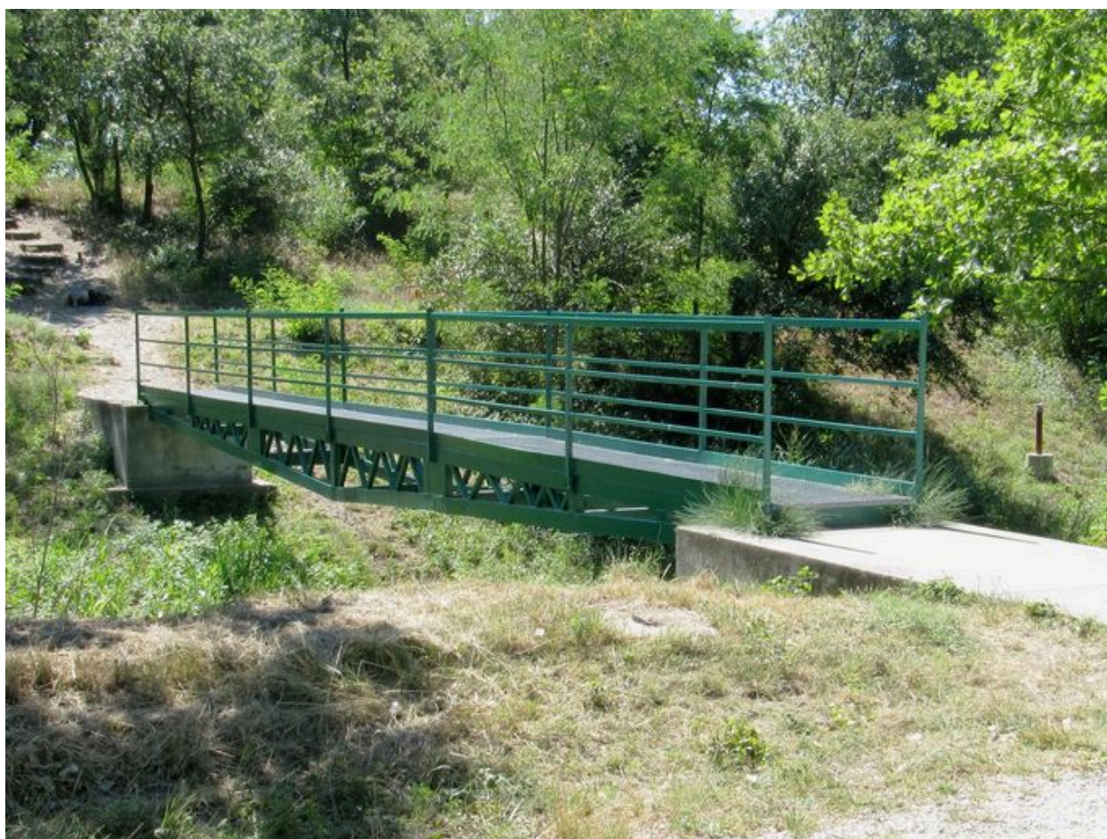
Passerelle métallique, sur la partie amont de la lône
