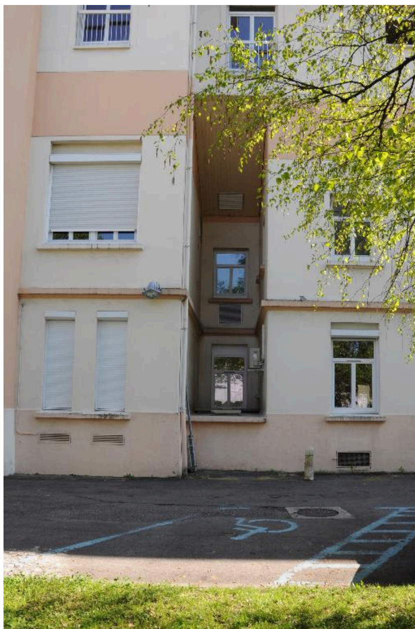
Façade postérieure, puits de lumière
