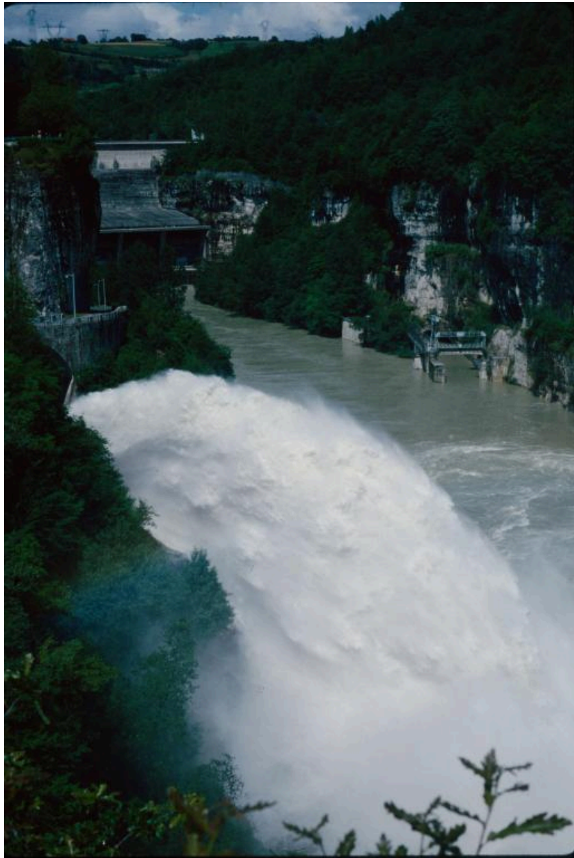
Déversoir de crue Génissiat, avril 1980 (archive privée)
