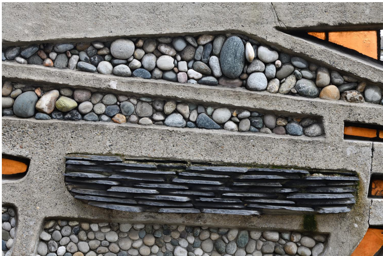
Seconde partie de l'installation, détail sur les matériaux.
