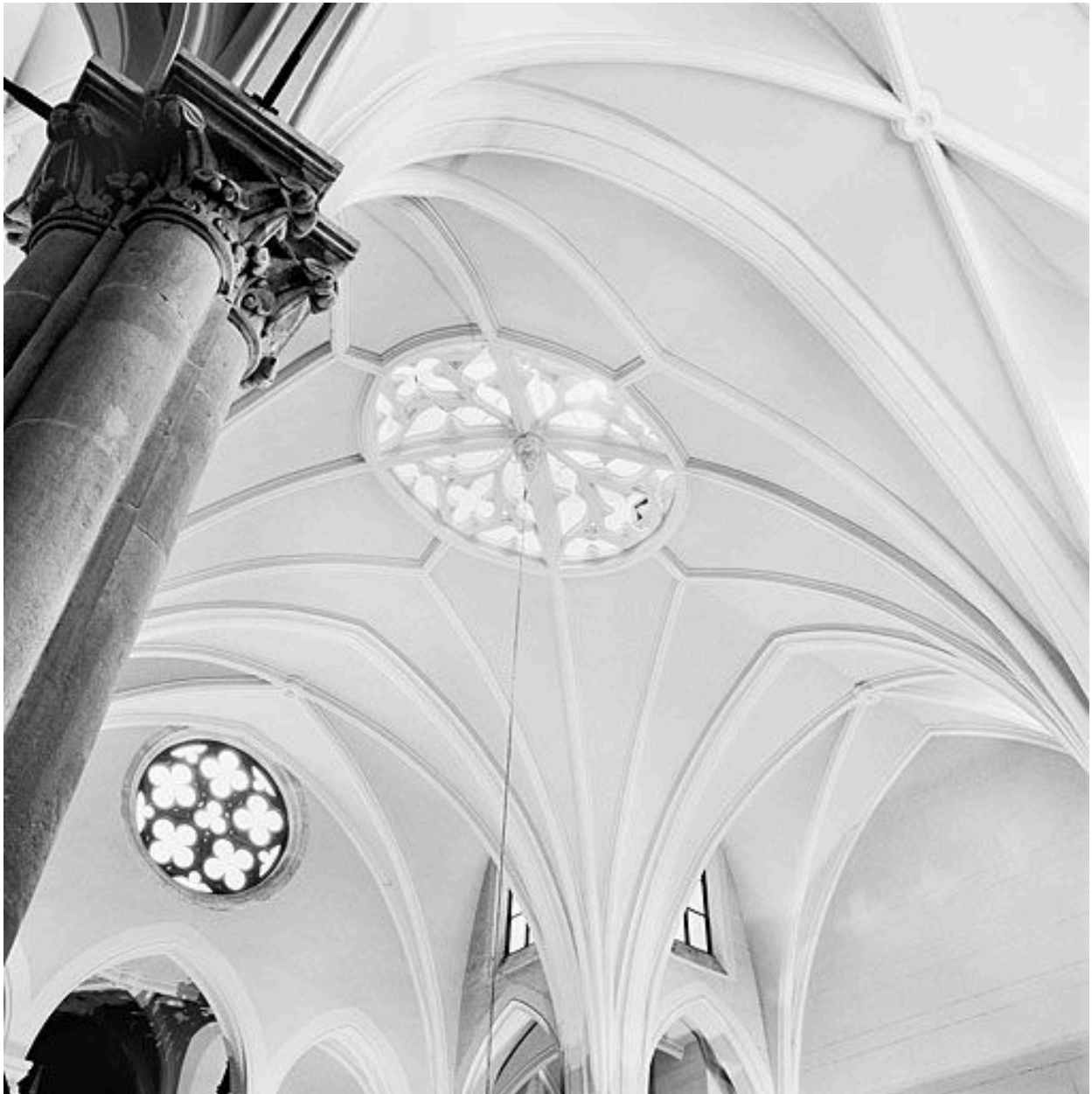
Eglise, voûte de la partie centrale
