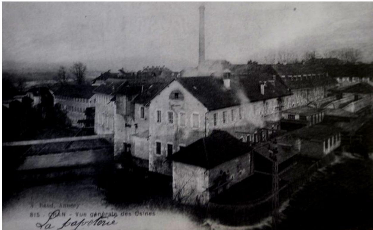
Cran.Vue générale des Usine.1906.
