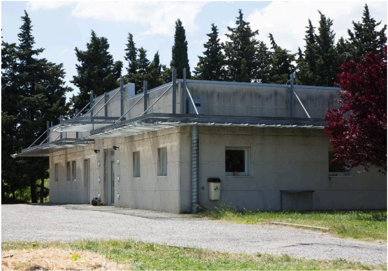
Station de grainage : façade ouest, entrée
