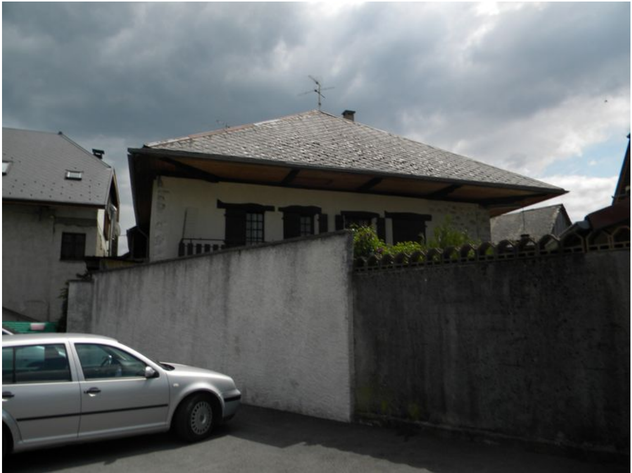
Façade arrière d'une ancienne ferme de la rue principale (C5 715).
