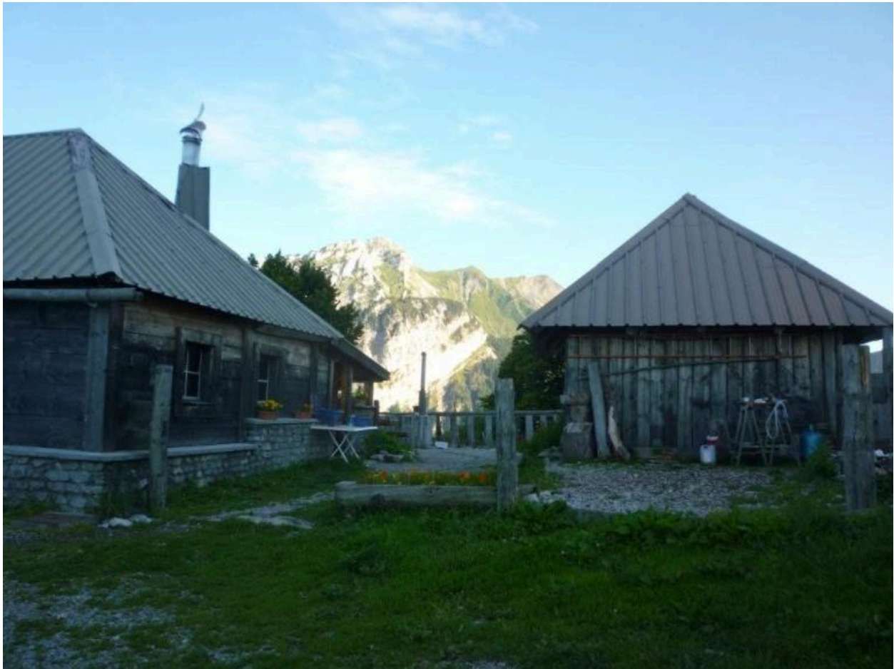
Vue du bâtiment d'habitation transformé en refuge et de l'abri à bois lui faisant face.
