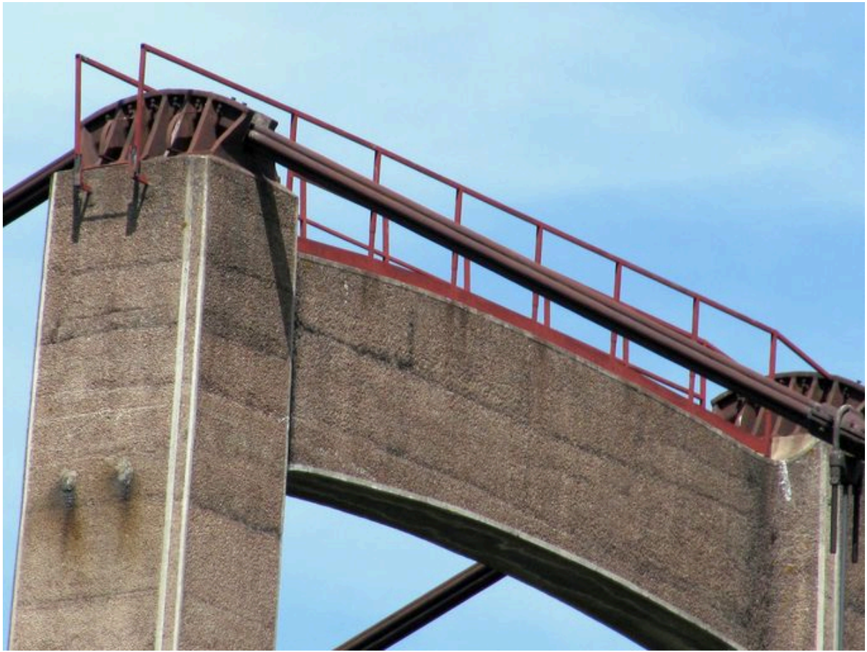
Pile gauche, face aval, vue de détail : passage du câble au sommet (depuis la rive gauche)
