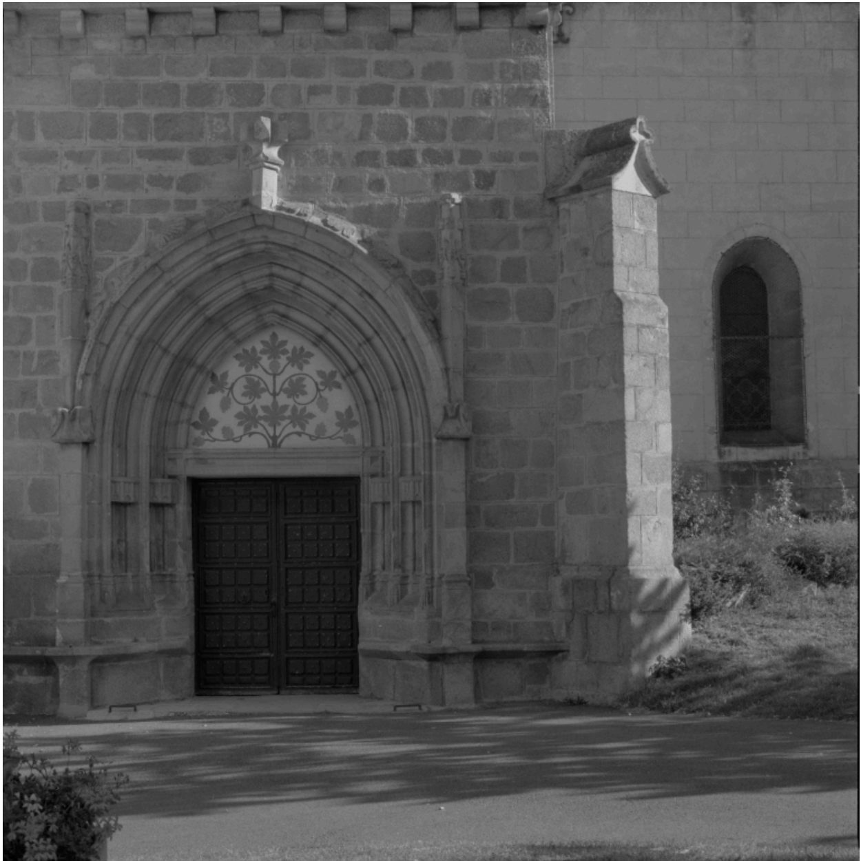
Vue d'ensemble du portail sud.
