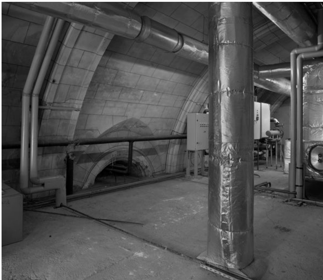
Bâtiment B, partie centrale, voûte de la chapelle
