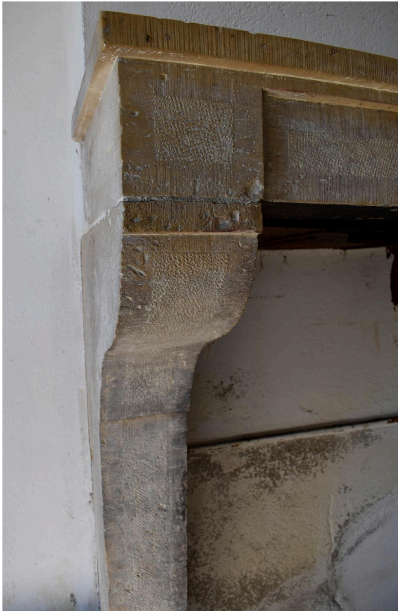
Détail de la cheminée de la cuisine.
