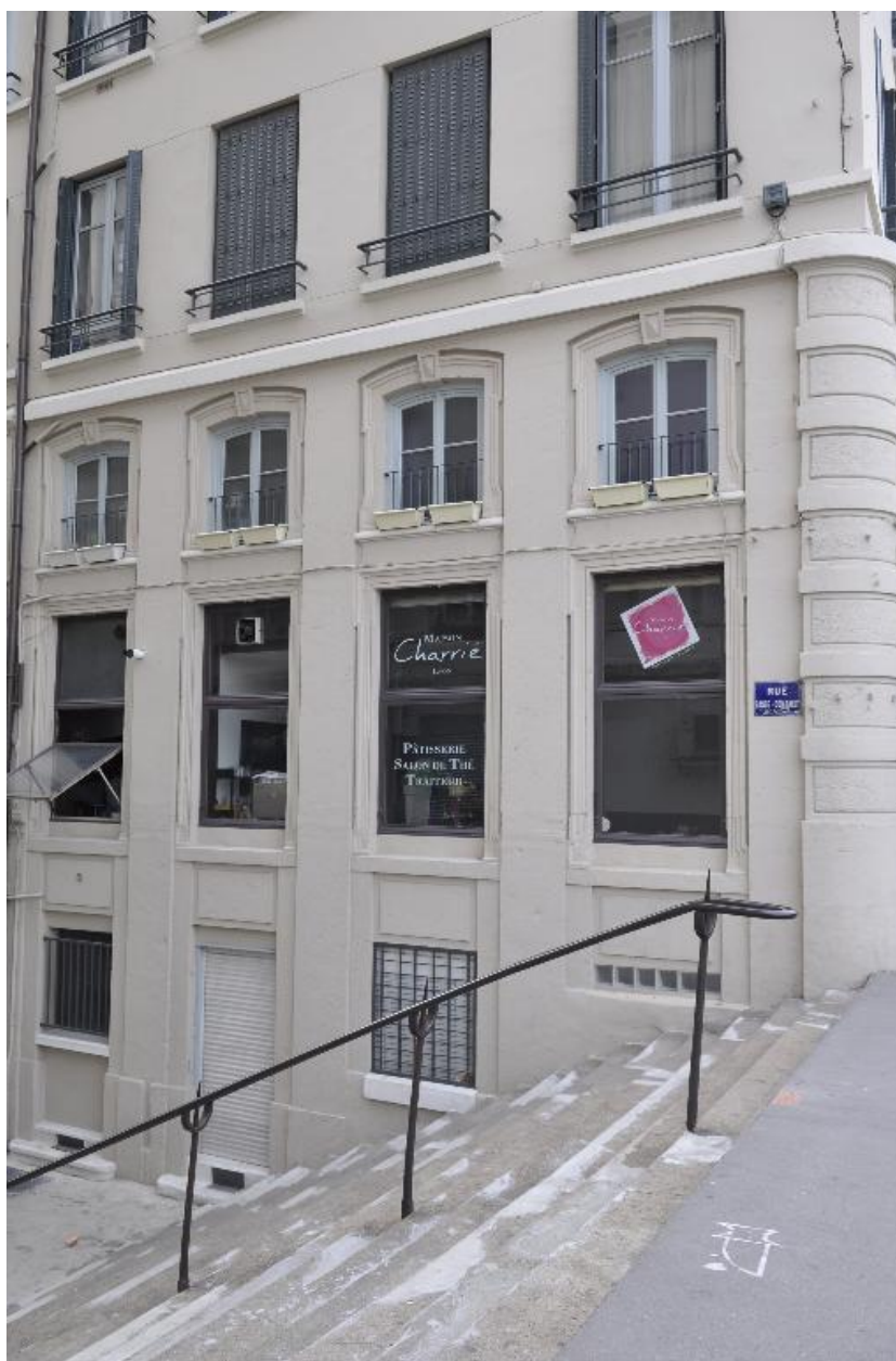
Bâtiment ouest, soubassement sur la rue Basse-Combalot
