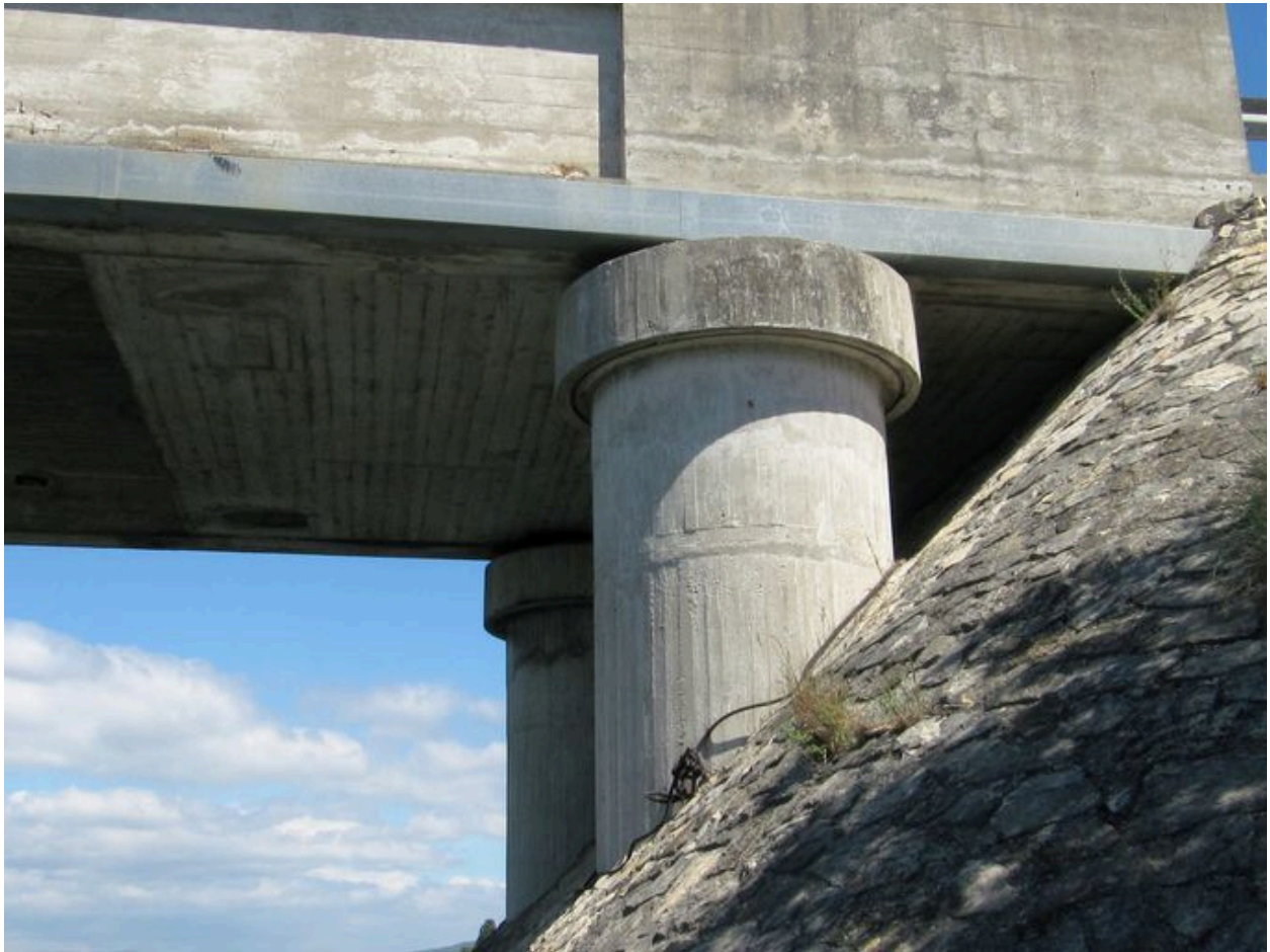
Culée de la rive gauche, face aval
