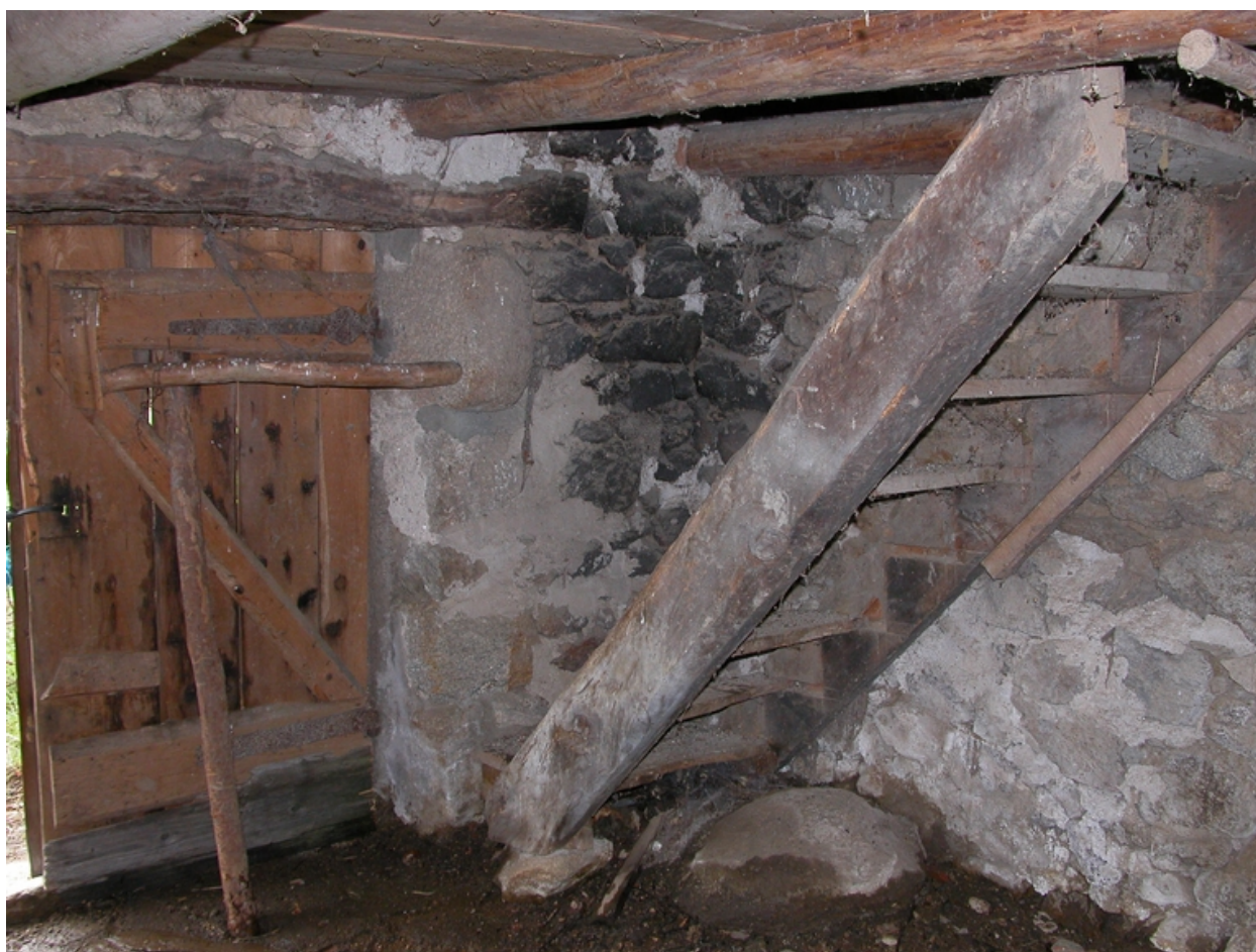
Vue du rez-de-chaussée.
