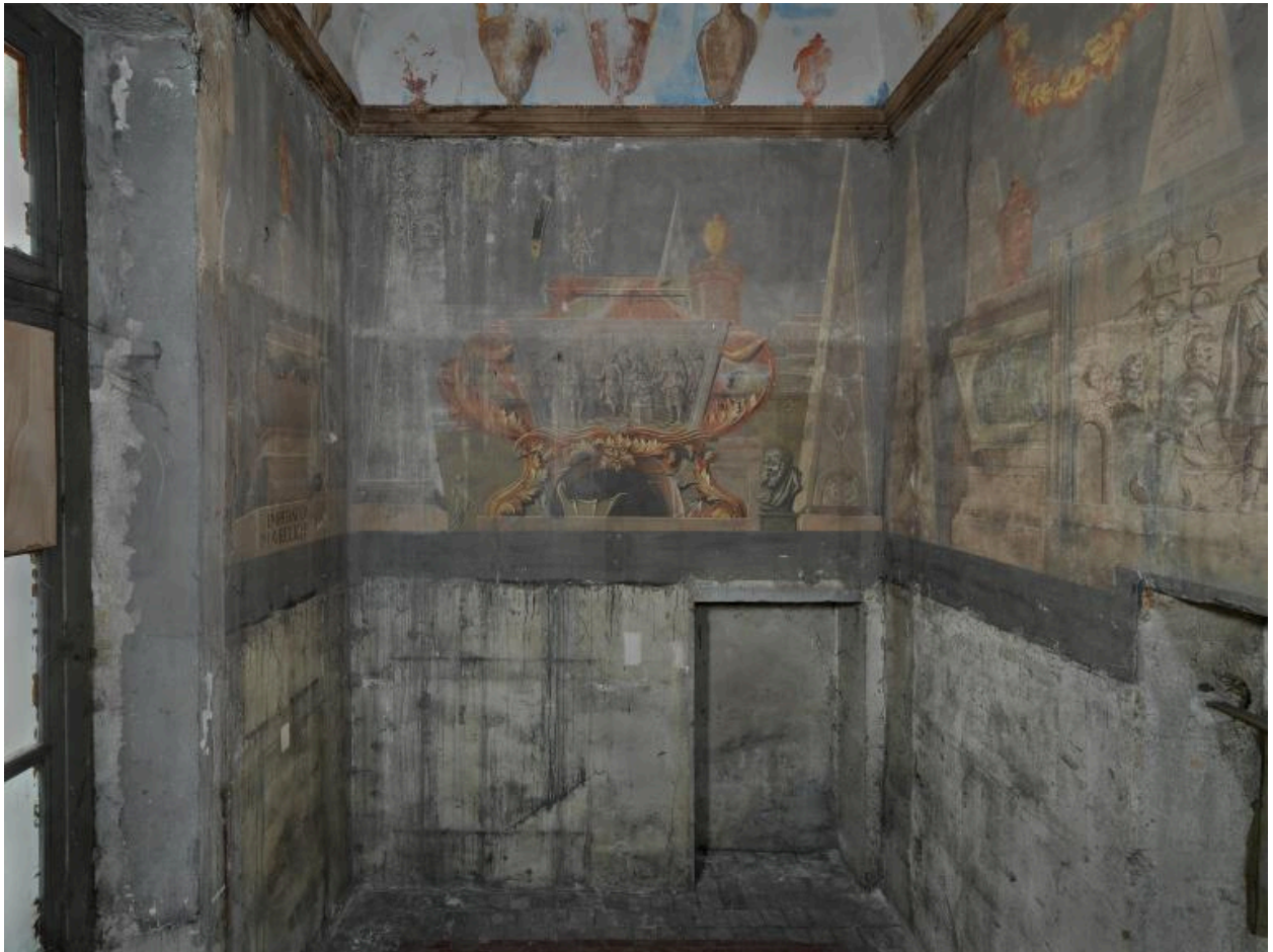
Mur ouest : vue d'ensemble après dépose des boiseries, sept. 2018
