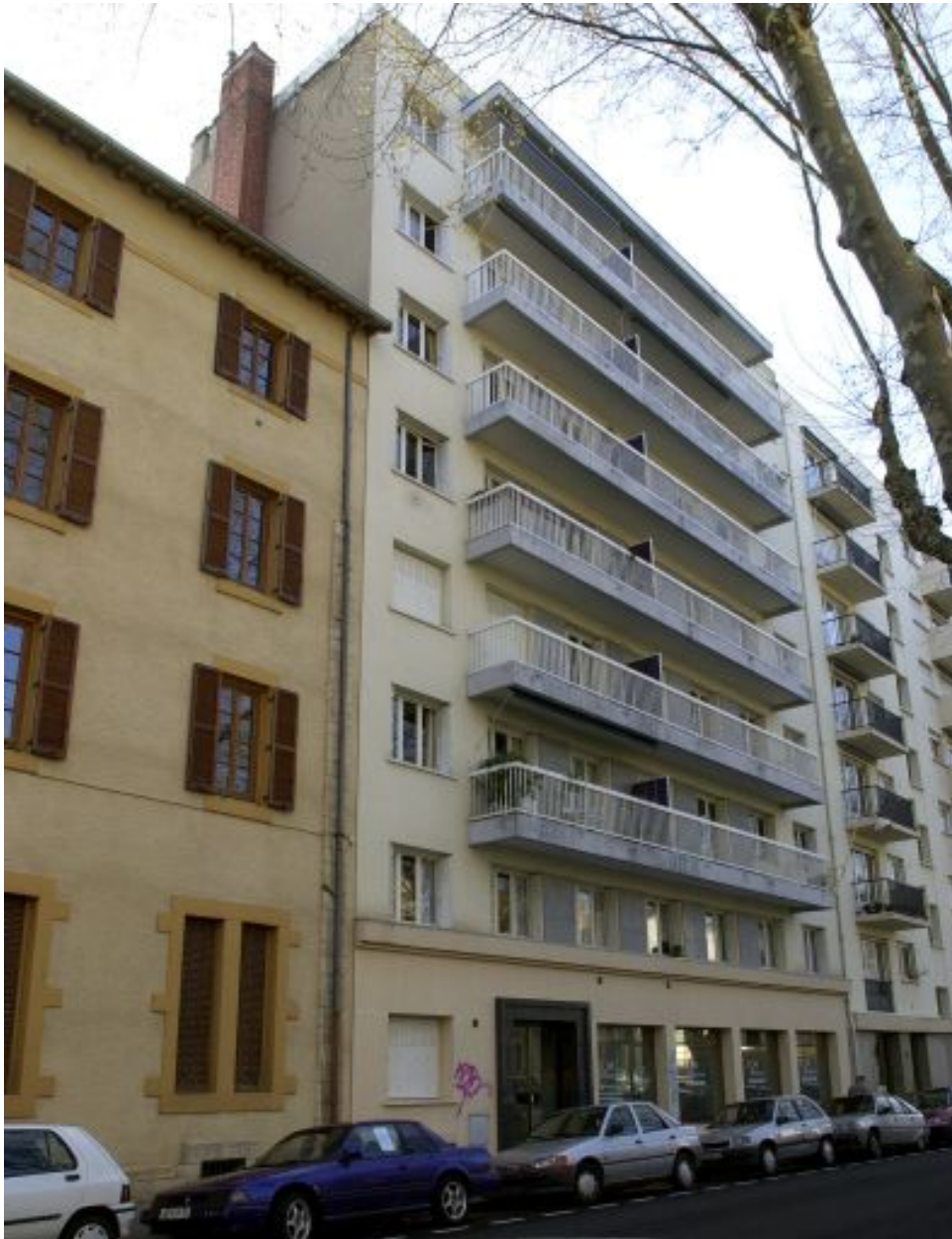
Elévation principale rue Smith depuis le nord
