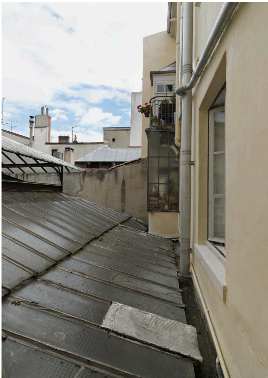
Elévation postérieure, détail d'une véranda et balconnet, verrière zénithale de la cour et cheneau
