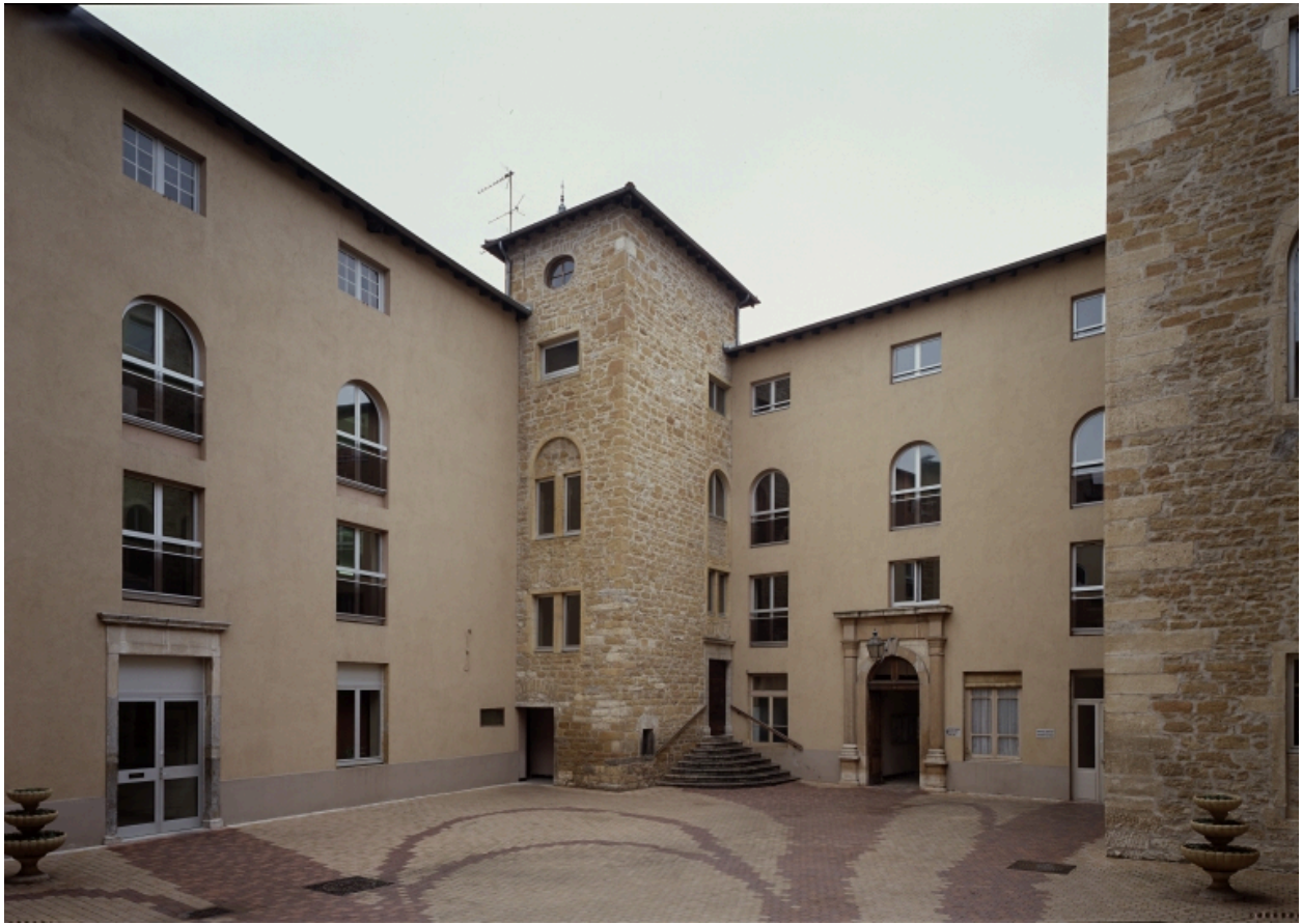
Vue d'ensemble de la cour intérieure, dont la tour d'escalier dans angle sud-ouest.
