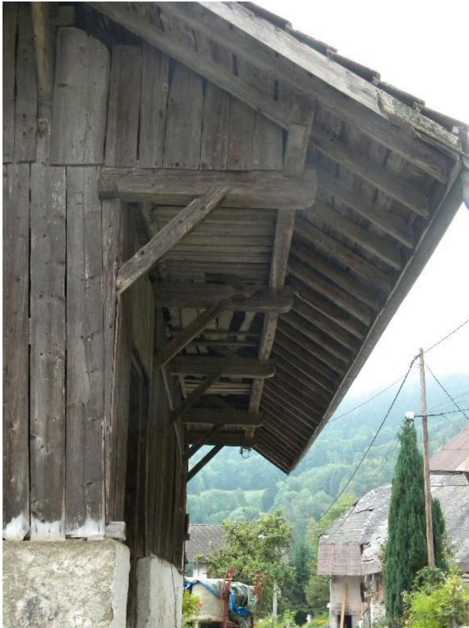
Vue du débord de toit sur la façade ouest.
