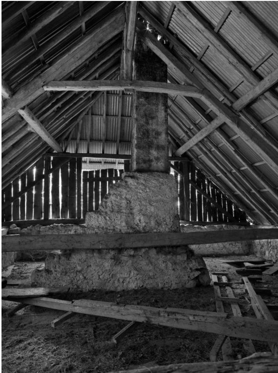
Vue d'ensemble du conduit de la cheminée et de la charpente de la ferme.
